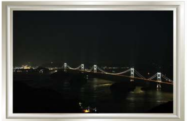
来島海峡大橋ライトアップ(亀老山から) 一矢 光一 2010.12.23
